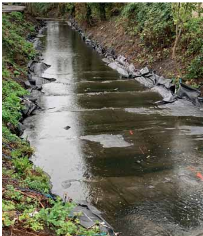
FIGUUR 4: REACTIEVE MAT IN DE LIEVE DIRECT NA AANLEG (DROGE PERIODE).
